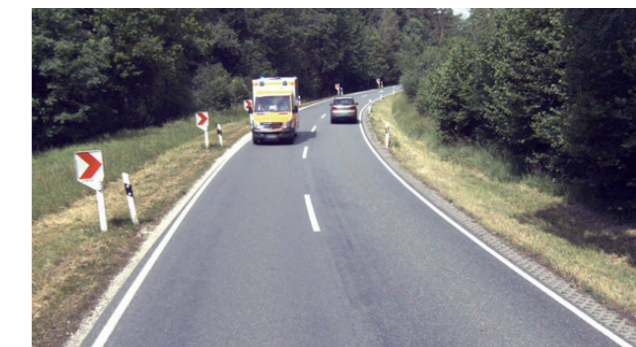
Abb. 21: Streckenfotos, links Vorher; rechts Nachher, der Zustandserfassung und-bewertung einer Kurve, an der flexible Richtungstafeln ausgestellt wurden [1]
