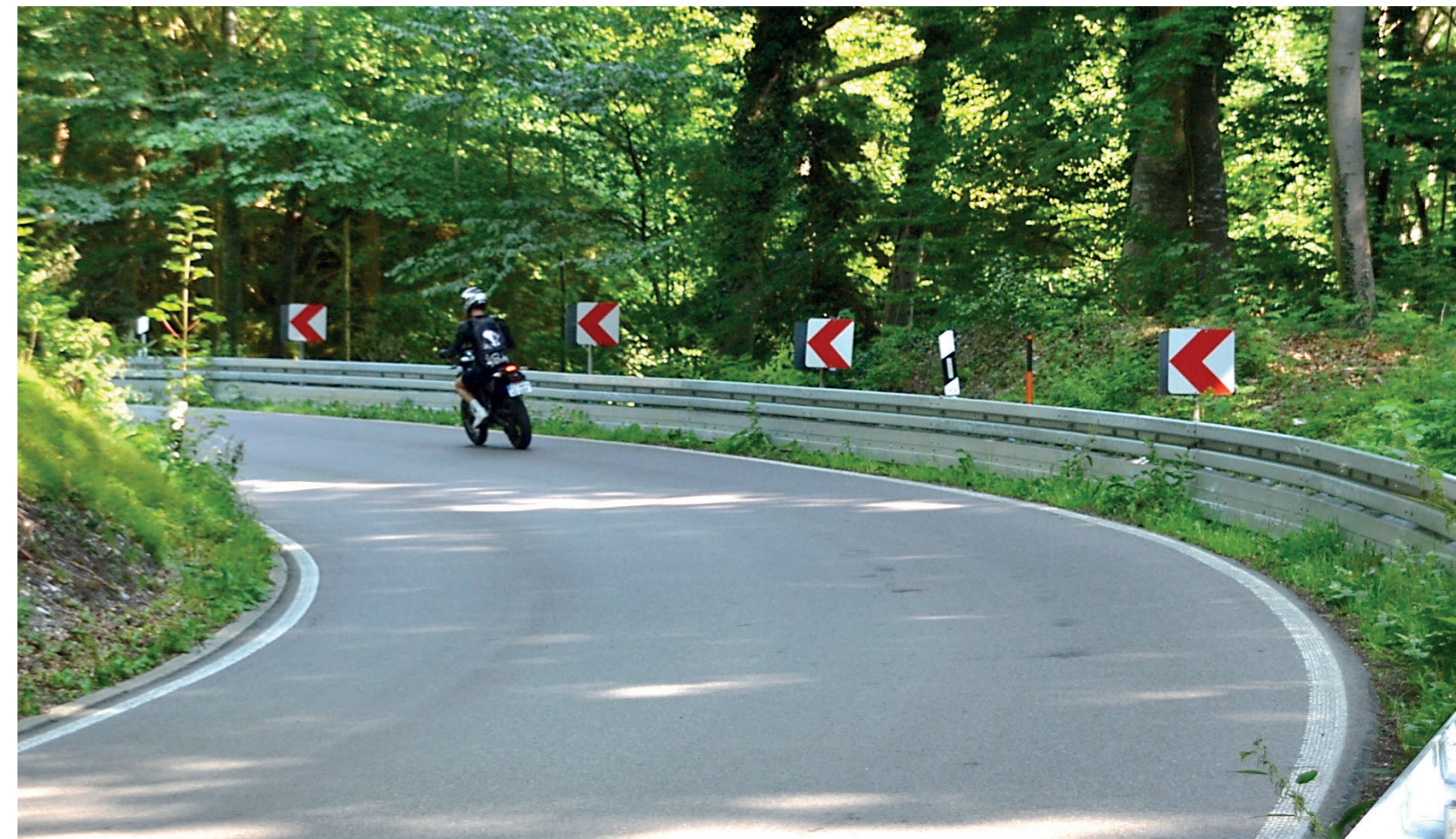
Abb. 27 Beispiel einer schlecht einsehbaren Kurve mit aufgelösten Richtungstafeln, Schutzplanke und Unterfahrerschutz
