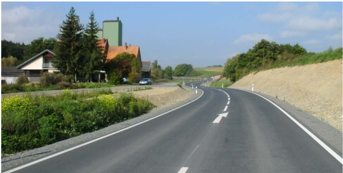
» Abb. 21 Streckenfoto einer ausgebauten Staatsstraße in Bayern, deren passiver Schutz infolge eines Sicherheitsaudits regelkonform nachgebessert wurde.
