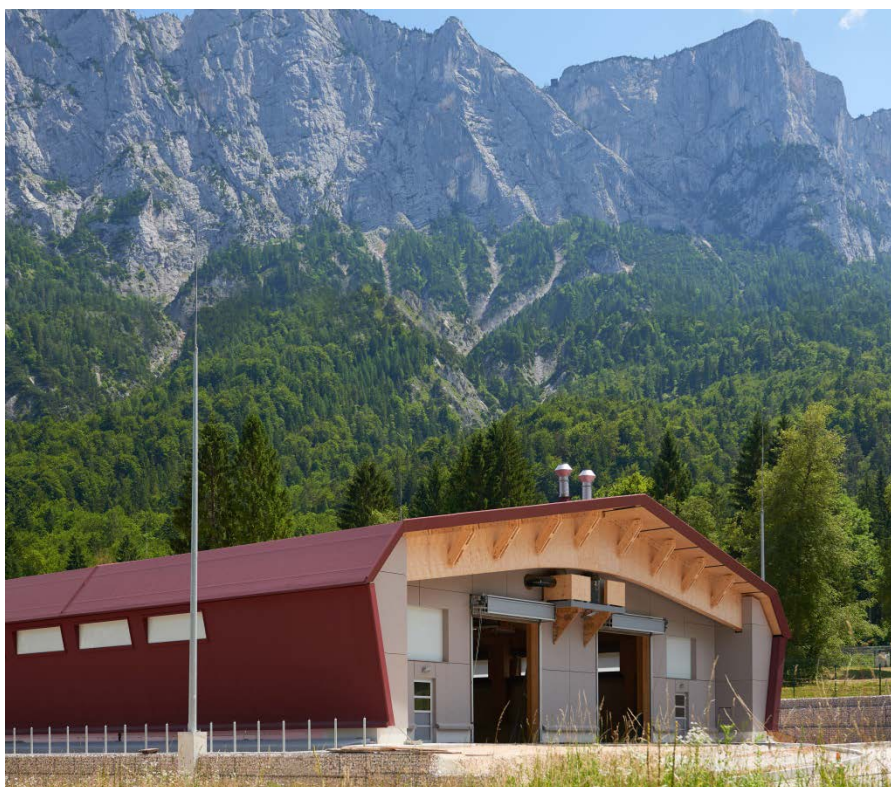
Nordwest-Fassade mit Zugangsbereich (Foto © H13 Ingenieure, München)
